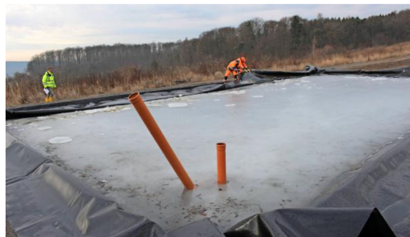
An einem der beiden neuen Biotop-Becken richten Abteilungsleiter Klaus Beez und seine Mitarbeiter die vom Wind umgeschlagene Dichtungsfolie. Foto: Gustav Döttling
